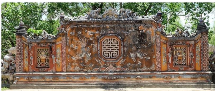
Hình 8 Các điêu khắc trang trí được thực hiện bằng kỹ thuật khảm mảnh sành sứ trên Bình phong ngoại án ở Cung Trường Sanh.
