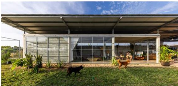
Hình 11 Mái hiên rộng 2 hướng nắng với kết cấu nhẹ Một số đề xuất nhằm vận dụng tốt giá trị không gian đệm vào công trình đương đại:
