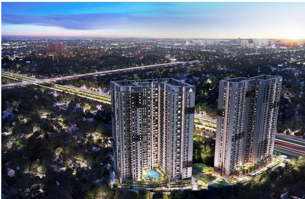
Hình 2.3 – Dự án Opal Boulevard
