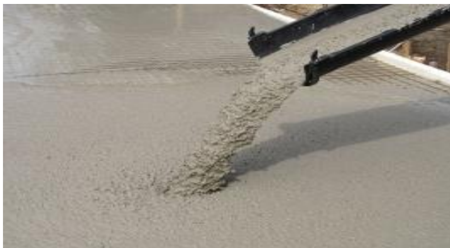
Hình 3: Sản xuất bê tông tươi
