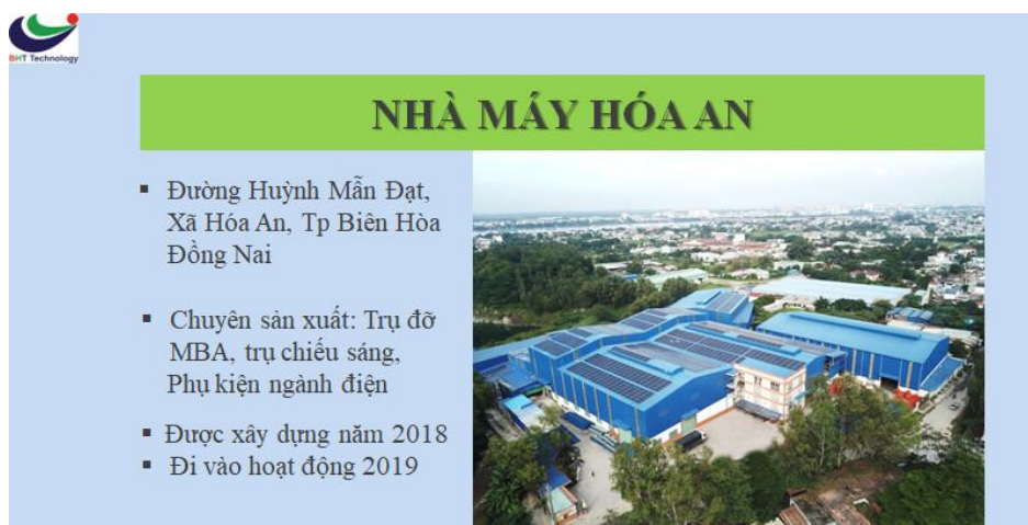
Hình 2. 2: Nhà máy sản xuất tại Hóa An
