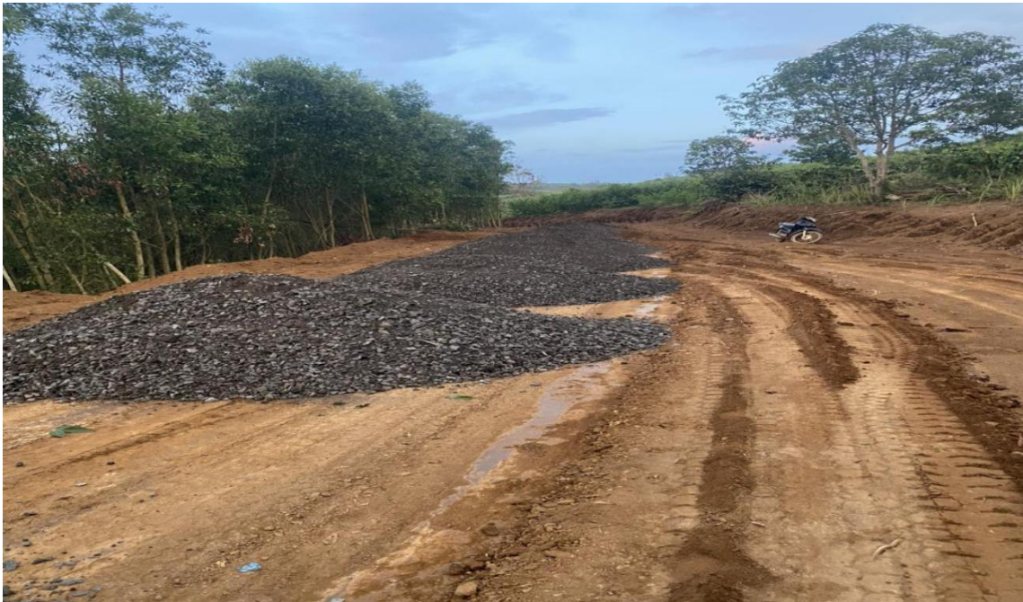
Hình 2.1: Công trình xây dựng đường bộ
