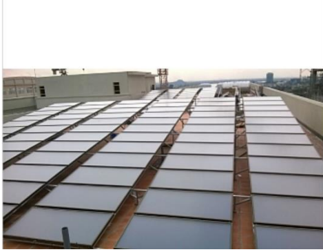
Hệ thống nước nóng năng lượng mặt trời công nghiệp Hinosun
